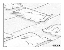
Die Bereiche entlang der Bodenkanten und die zuletzt verlegten Reihen sind besonders wichtig. Der Boden sollte erst nach dem Aushärten des Klebstoffs benutzt werden. Der Boden sollte erst mindestens 48 Stunden nach der vollflächigen Verklebung abgeschliffen und behandelt werden.
